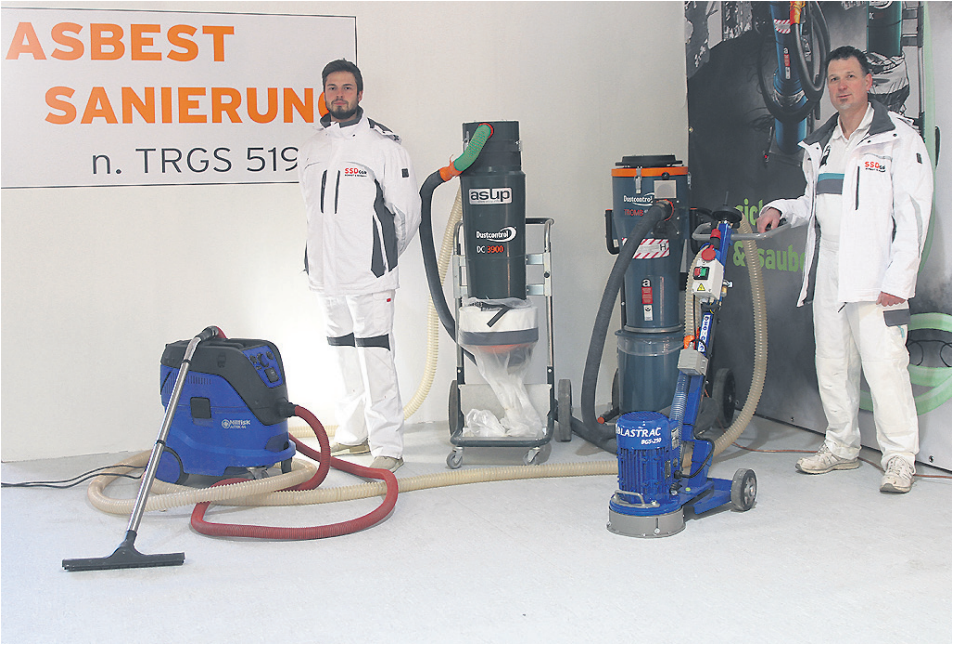
Mit Spezialmaschinen wird eine saubere und fachgerechte Asbest-Sanierung gewährleistet.
